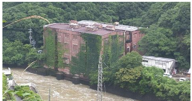
関電所有の旧志津川発電所
