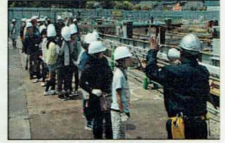
工事現場見学会
