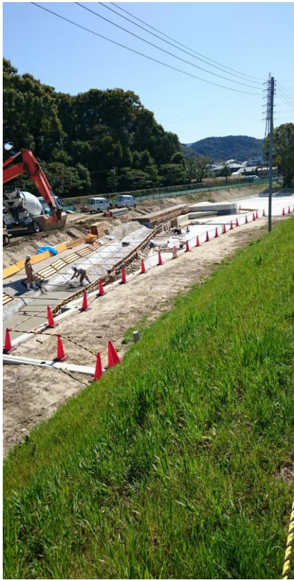
工事中の太閤堤跡地域の史跡ゾーン
