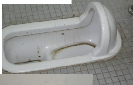
北小倉小学校のトイレ
